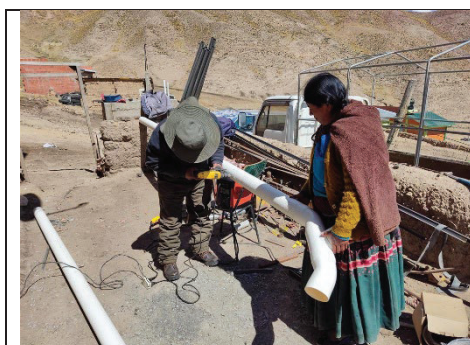
Refacción del sistema de agua comunidad Champuyo - Municipio Yaco
