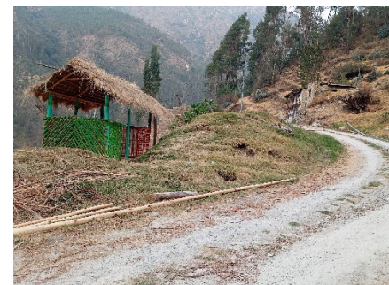
Centro de acopio de RRSS comunal PMS Lambrama
